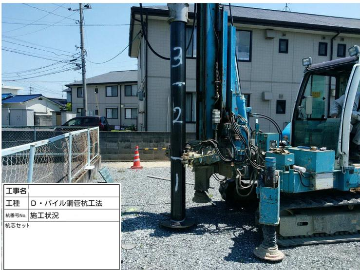
D・パイル杭工法の最大の特徴は、杭先端の回転翼です。翼の無い鋼管に比べて支持力が強化されます。
